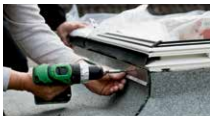
Profile mocujące pokrycie dachu do okna ZZZ 210
