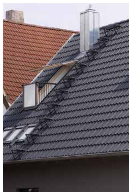
Dachówka ze strzemieniem pod ławę kominiarską
